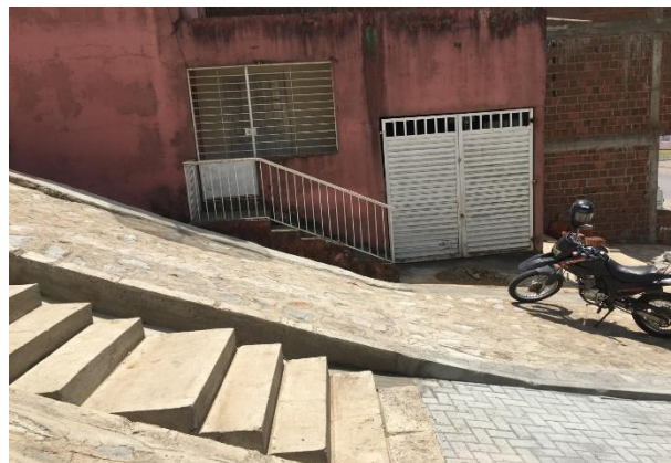
FOTO 20: Execução de escadaria em concreto.
