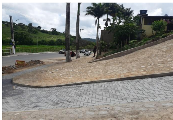
FOTO 18: Execução de calçada com intertravado e meio fio.
