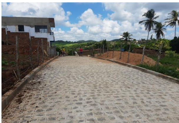
FOTO 9: Pavimentação em paralelepípedos no Sítio Bela Vista/Brejinhos.
