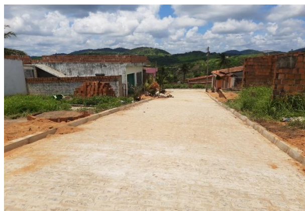
FOTO 12: Pavimentação em paralelepípedos no Sítio Bela Vista/Brejinhos.
