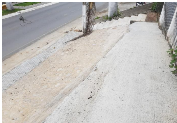
FOTO 24: Regularização de superfície com concreto simples.
