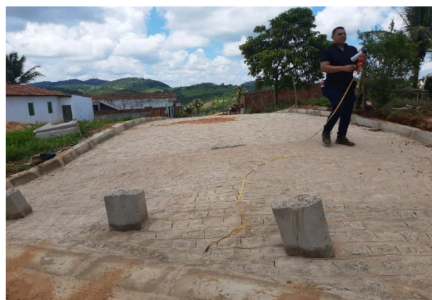
FOTO 6: Pavimentação em paralelepípedos no Sítio Bela Vista/Brejinhos.
