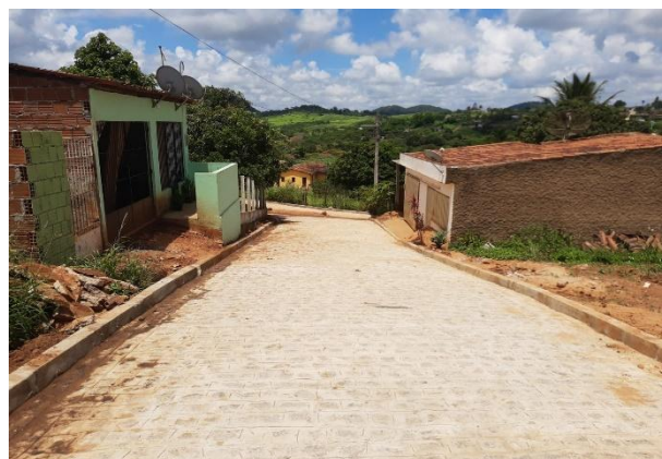
FOTO 10: Pavimentação em paralelepípedos no Sítio Bela Vista/Brejinhos.
