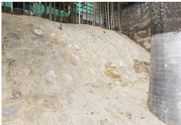
FOTO 13: Revestimento do talude com pedra argamassada.
