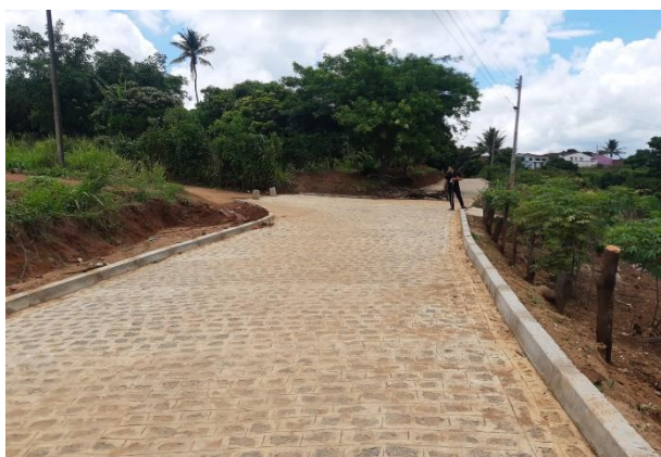
FOTO 11: Pavimentação em paralelepípedos no Sítio Bela Vista/Brejinhos.
