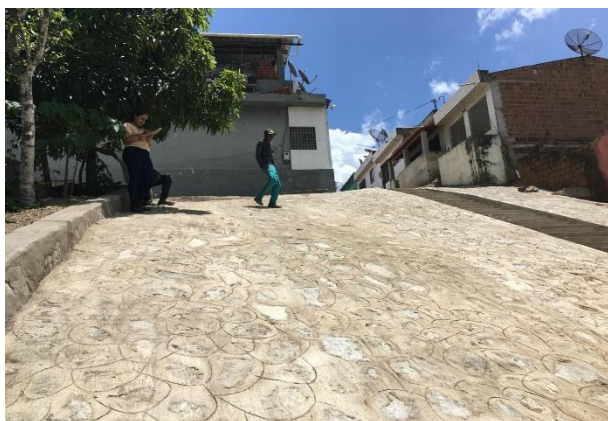
FOTO 15: Revestimento do talude com pedra argamassada.
