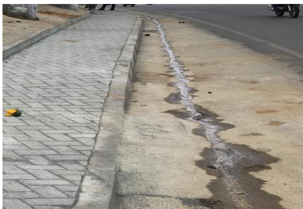
FOTO 23: Execução de canaleta em concreto simples.
