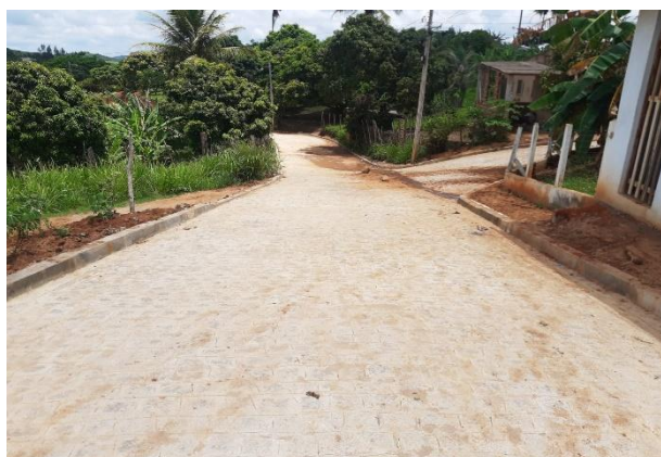
FOTO 5: Pavimentação em paralelepípedos no Sítio Bela Vista/Brejinhos.
