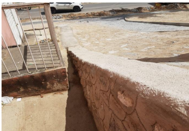
FOTO 21: Execução de muro de arrimo.
