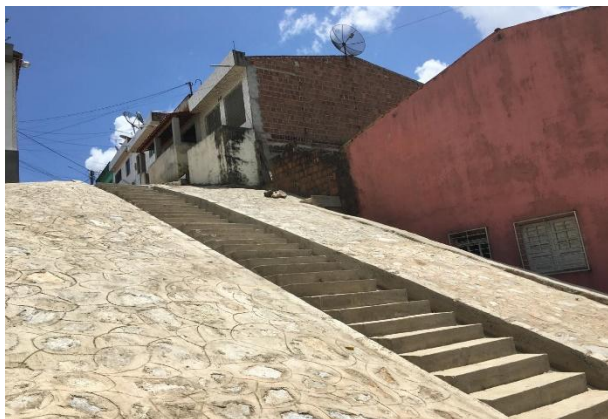
FOTO 19: Execução de escadaria em concreto.
