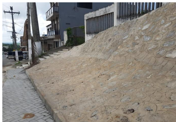
FOTO 16: Revestimento do talude com pedra argamassada.
