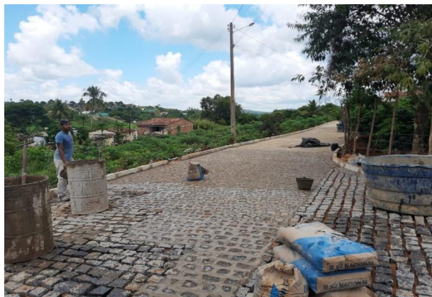
FOTO 1: Pavimentação em paralelepípedos no Sítio Bela Vista/Brejinhos.
