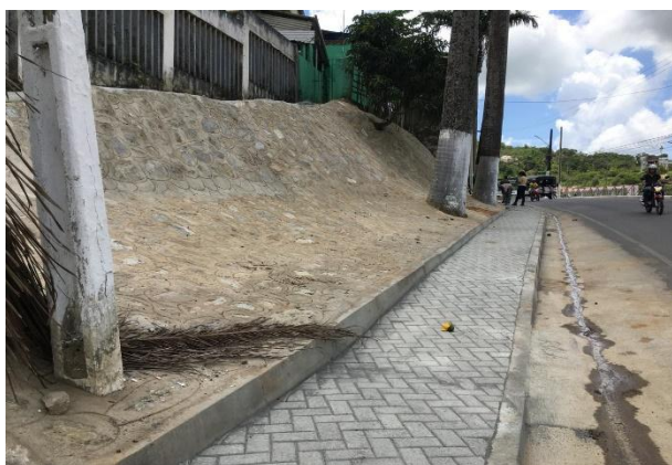
FOTO 17: Execução de calçada com intertravado e meio fio.
