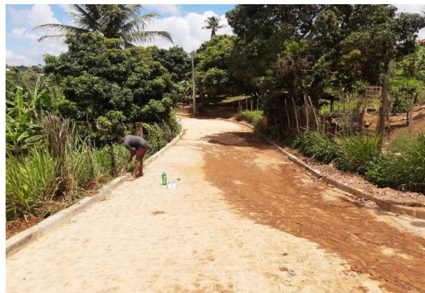
FOTO 8: Pavimentação em paralelepípedos no Sítio Bela Vista/Brejinhos.
