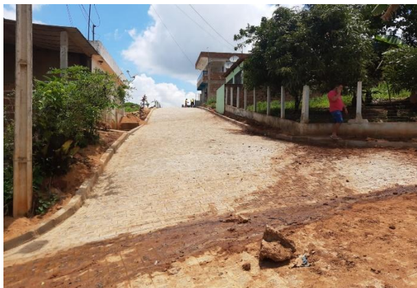
FOTO 7: Pavimentação em paralelepípedos no Sítio Bela Vista/Brejinhos.
