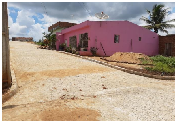
FOTO 4: Pavimentação em paralelepípedos no Sítio Bela Vista/Brejinhos.
