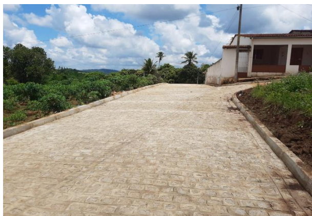
FOTO 3: Pavimentação em paralelepípedos no Sítio Bela Vista/Brejinhos.
