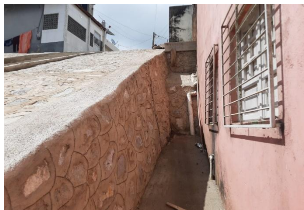
FOTO 22: Execução de muro de arrimo.
