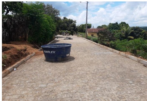
FOTO 2: Pavimentação em paralelepípedos no Sítio Bela Vista/Brejinhos.
