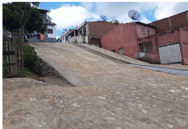
FOTO 14: Revestimento do talude com pedra argamassada.
