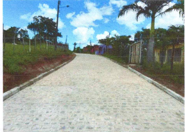
FOTO 4: Pavimentação em paralelepípedos no Sitio Melancia - Rua Projetada.
