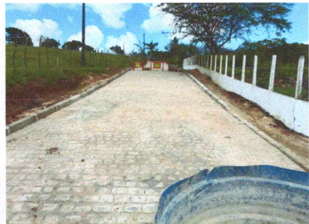
FOTO 6: Pavimentação em paralelepípedos no Sitio Melancia - Rua Projetada.
