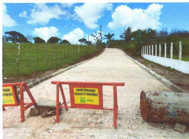
FOTO 5: Pavimentação em paralelepípedos no Sitio Melancia - Rua Projetada.
