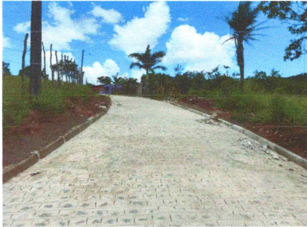
FOTO 1: Pavimentação em paralelepípedos no Sitio Melancia - Rua Projetada.
