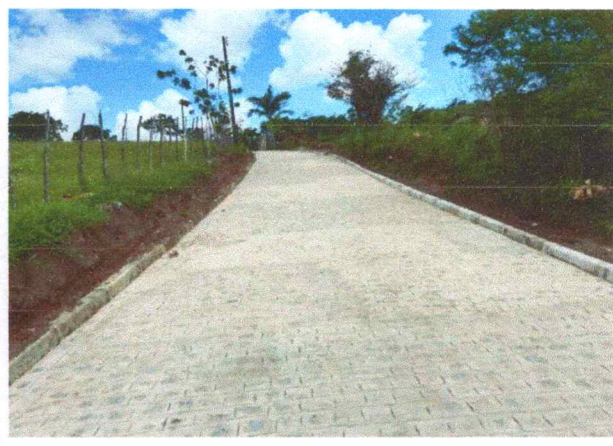
FOTO 2: Pavimentação em paralelepípedos no Sitio Melancia - Rua Projetada.
