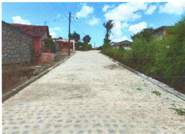
FOTO 3: Pavimentação em paralelepípedos no Sitio Melancia - Rua Projetada.
