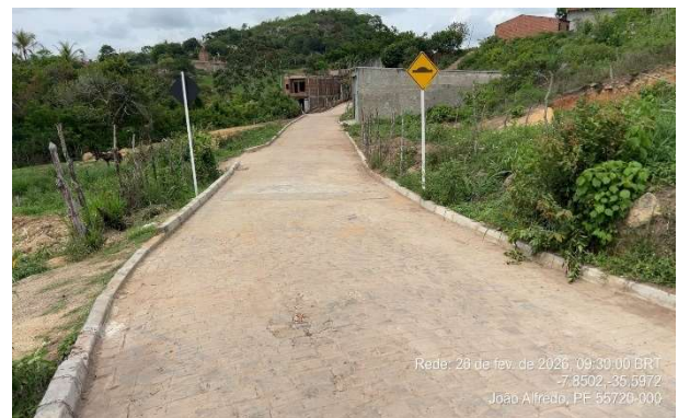
FOTO 6: Rua 2 – Pavimentação em paralelepípedos.
