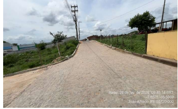
FOTO 2: Rua 2 – Pavimentação em paralelepípedos.
