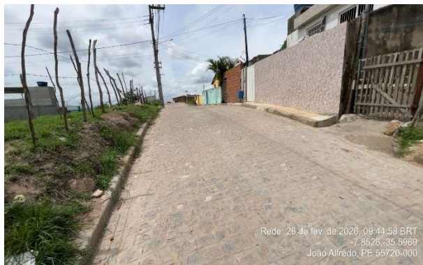
FOTO 3: Rua 2 – Pavimentação em paralelepípedos.
