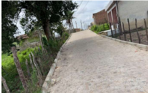
FOTO 1: Rua 2 – Pavimentação em paralelepípedos.
