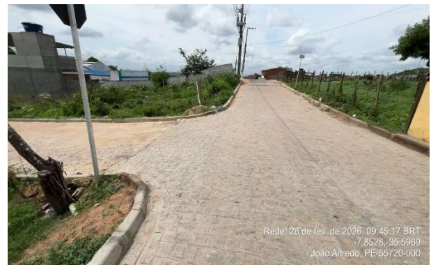
FOTO 4: Rua 2 – Pavimentação em paralelepípedos.
