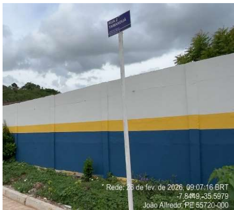
FOTO 7: Sinalização – Placa de identificação de rua.
