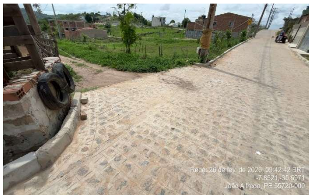
FOTO 5: Rua 2 – Pavimentação em paralelepípedos.
