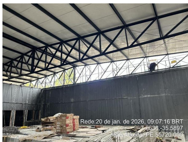
FOTO 3: Coberta com telha termoacústica.
