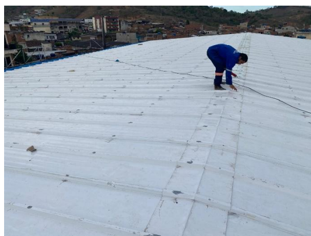
FOTO 4: Coberta com telha termoacústica.
