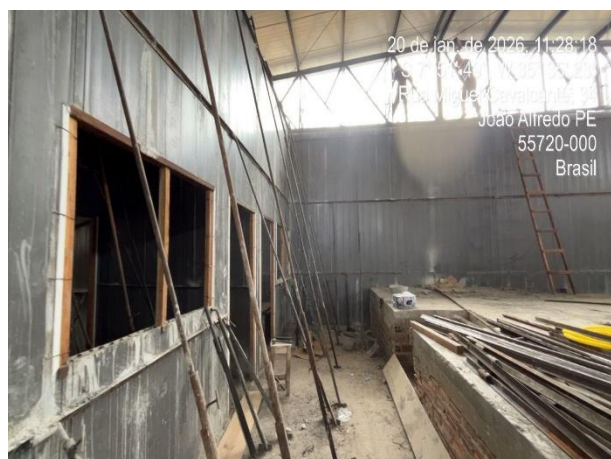
FOTO 9: Montagem, escoramento e concretagem das paredes de PVC.
