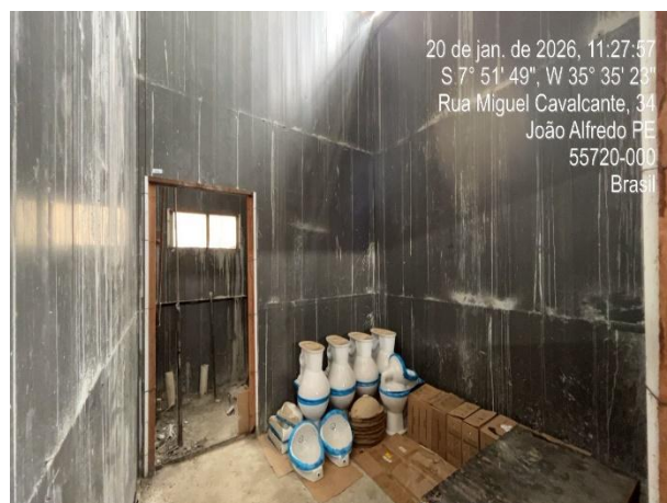
FOTO 10: Montagem, escoramento e concretagem das paredes de PVC.
