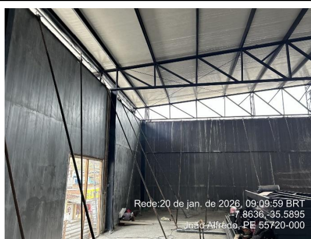
FOTO 8: Montagem, escoramento e concretagem das paredes de PVC.
