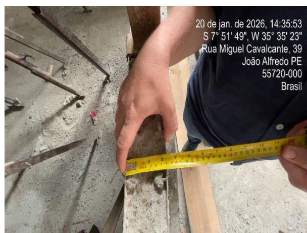
FOTO 12: Montagem, escoramento e concretagem das paredes de PVC.
