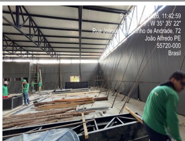
FOTO 7: Montagem, escoramento e concretagem das paredes de PVC.
