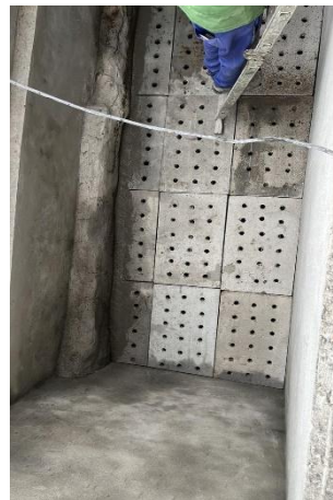
FOTO 4: Execução de fossa e filtro.
