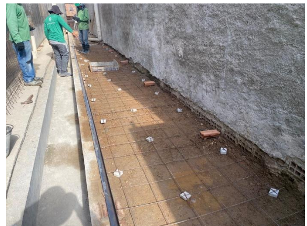
FOTO 6: Execução de canaleta e calçada lateral.
