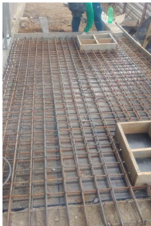
FOTO 3: Execução de fossa e filtro.
