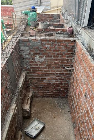
FOTO 1: Execução de fossa e filtro.
