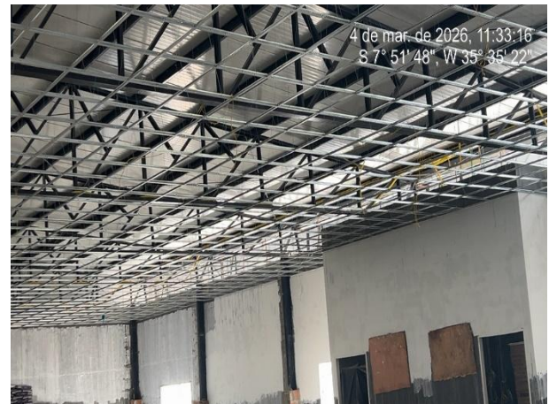
FOTO 8: Instalação da estrutura para receber o forro de gesso.
