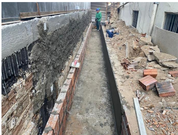
FOTO 5: Execução de canaleta e calçada lateral.
