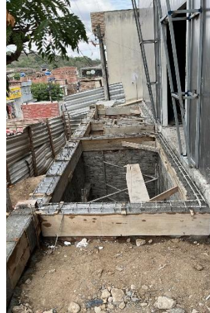
FOTO 2: Execução de fossa e filtro.
