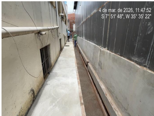
FOTO 7: Execução de canaleta e calçada lateral.
