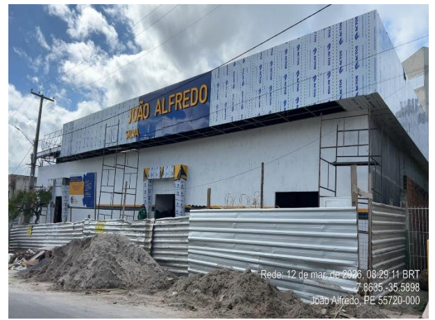
FOTO 14: Instalação de ACM em fachada.
