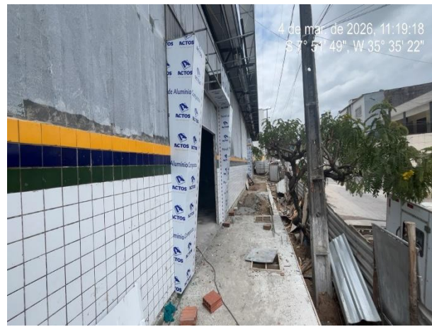
FOTO 13: Aplicação de cerâmica em paredes.
