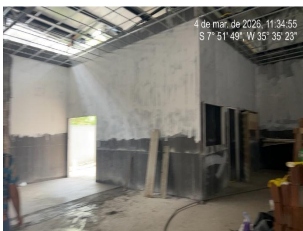
FOTO 05: Aplicação de fundo selador em paredes.
