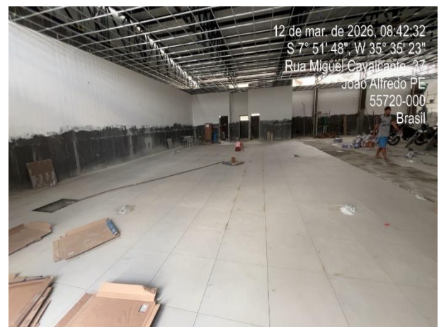
FOTO 04: Aplicação de fundo selador em paredes.
